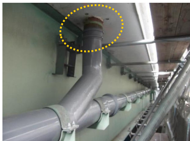
<ドレージョイント施工例>
